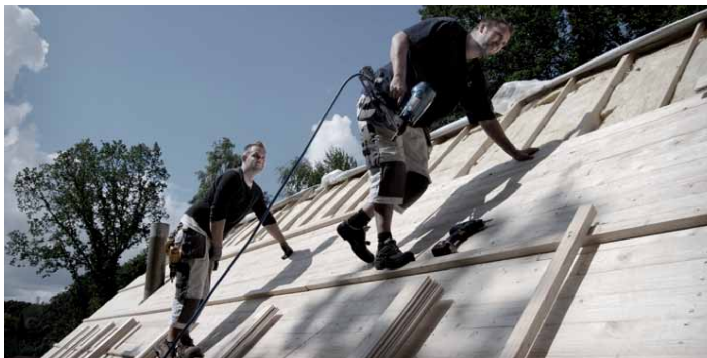
Husk at tænke på ventilation, når huset tættes, som her hvor taget efterisoleres.
